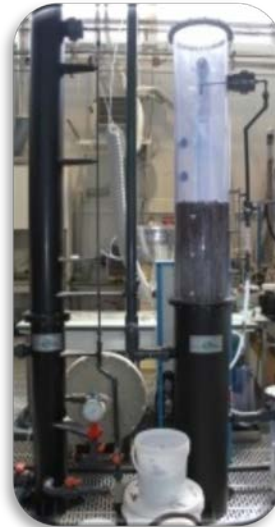
Pilote de traitement d'H 2 S par biofiltration
